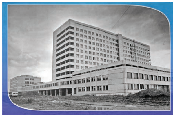
Здание ККЦ на этапе строительства
