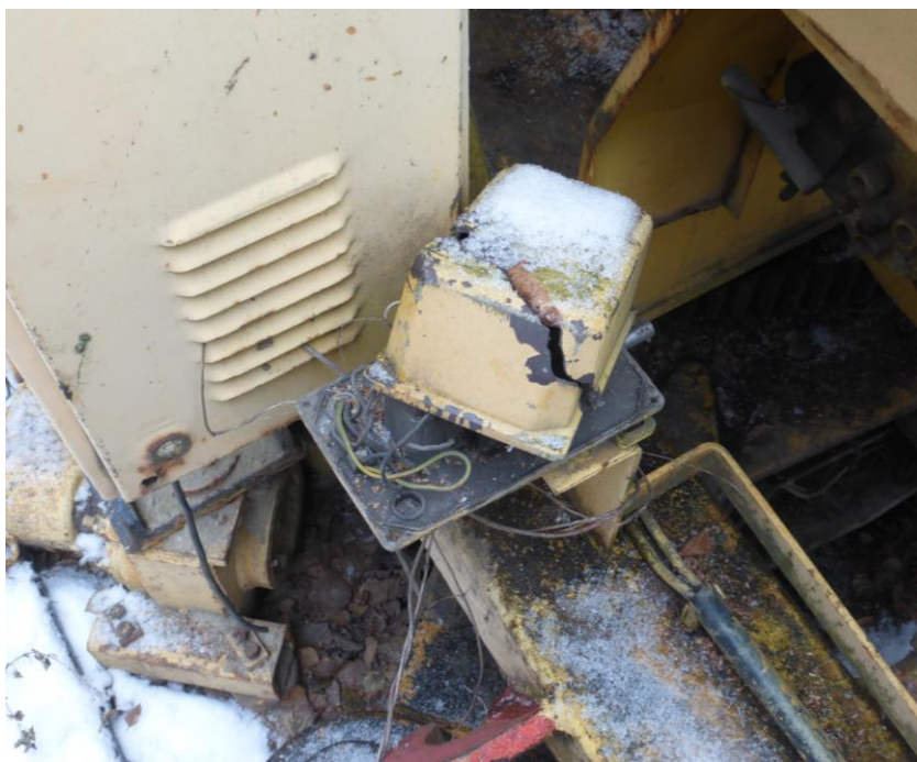
Рис.1 Разрушение металлоконструкций башенного крана (Liebherr)
